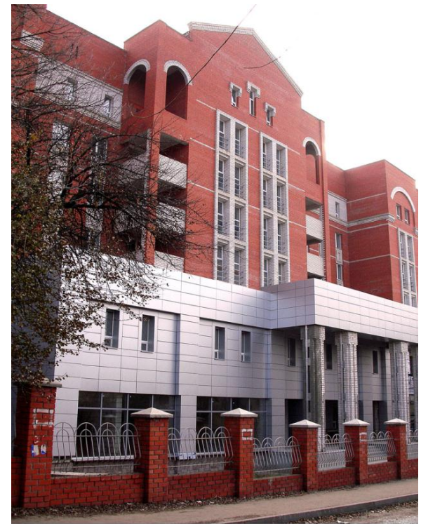
Хирургический корпус железнодорожной больницы г. Воронеж (2006 г.)
